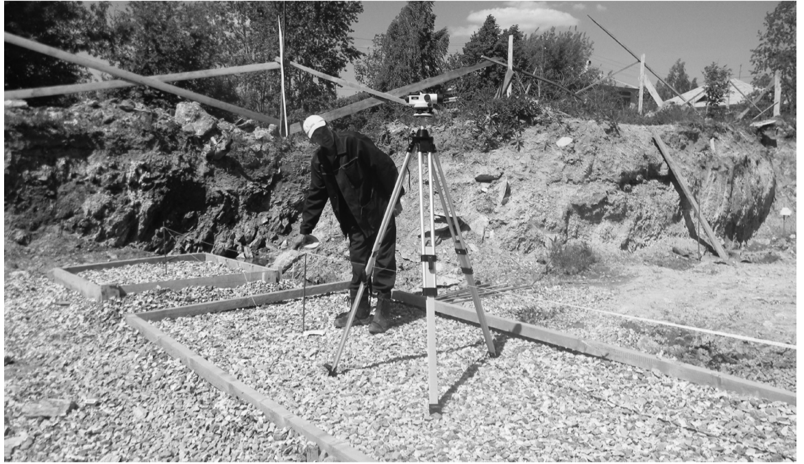
В котловане началась подготовка к бетонированию основания под фундамент
